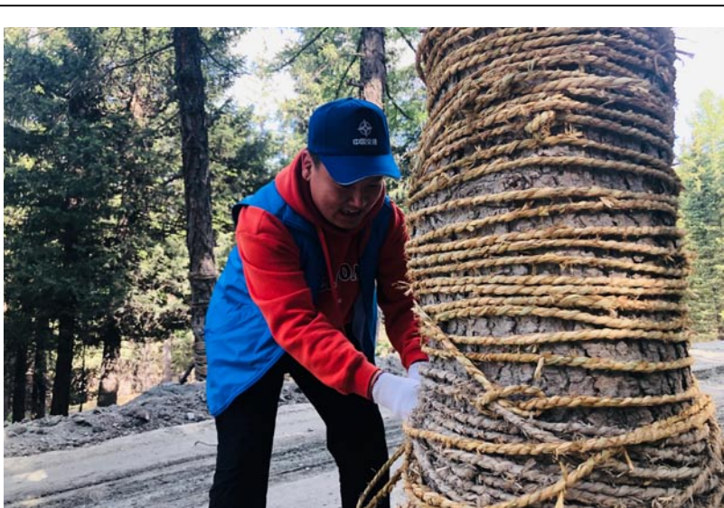
9月，新疆即将进入秋冬季节，为防止海拔2400米斜井施工区树木被冻坏，桥隧公司新疆G575项目绑扎秸秆麻绳保护树木。曹英丽/摄影报道
