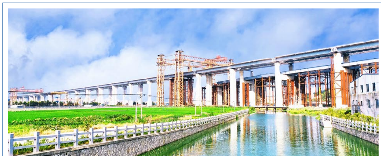
8月23日，二公司承建的世界首座三塔四跨双层钢桁梁悬索桥——温州瓯江北口大桥北引桥钢混组合梁钢梁全部顶推完成。北引桥全长3.22公里，全桥钢梁共501节段，总重约1.9万吨，顶推施工长达1.01公里，最大顶推
